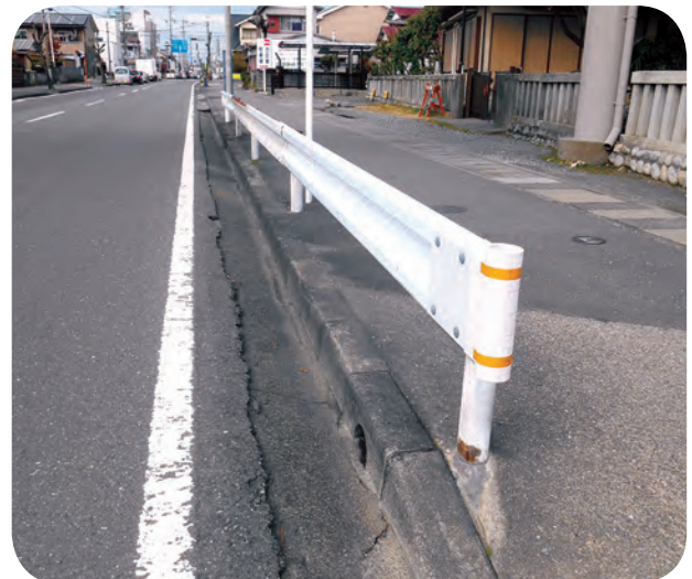
ガードレール
