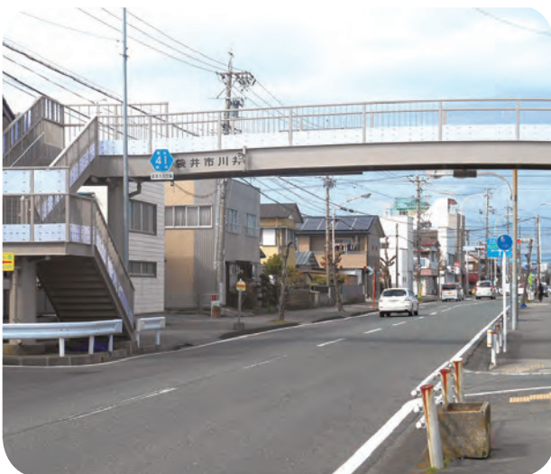
横だん歩道橋
