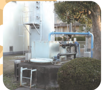
袋井第一水源地 (上田町) 地下からくみ上げられた水を消毒し、寺谷浄水場から送られてきた水と混ぜて各家庭に送られます。
