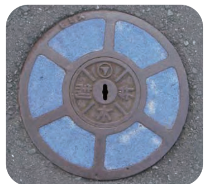
上水道管上のマンホール
