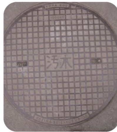
下水道管上のマンホール
