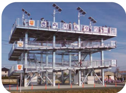
つなみ ひなん せつち 津波避難タワーの設置
