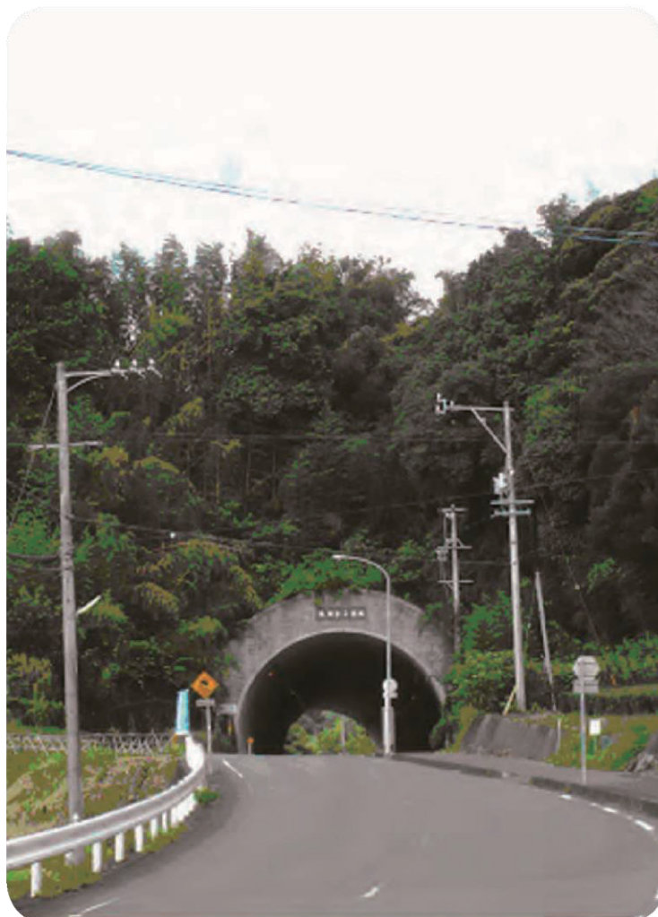
今の大日 ずいどう 隧道 (大日トンネル)
